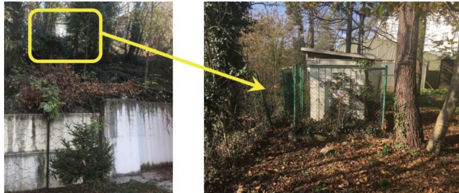
Şekil 6 - 8105 kodlu kayıt istasyonunun görünüşü
