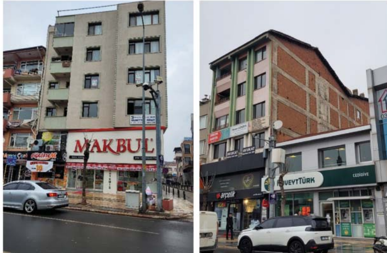
Şekil 14 - Güçlendirilmiş binaların Gölyaka depremi sonrası durumları
