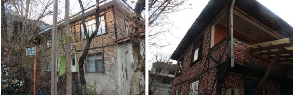
Şekil 13 - Hasarsız hımış bina örnekleri
