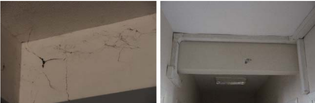
Şekil 11 - Betonarme binalarda yapısal hasar örnekleri
