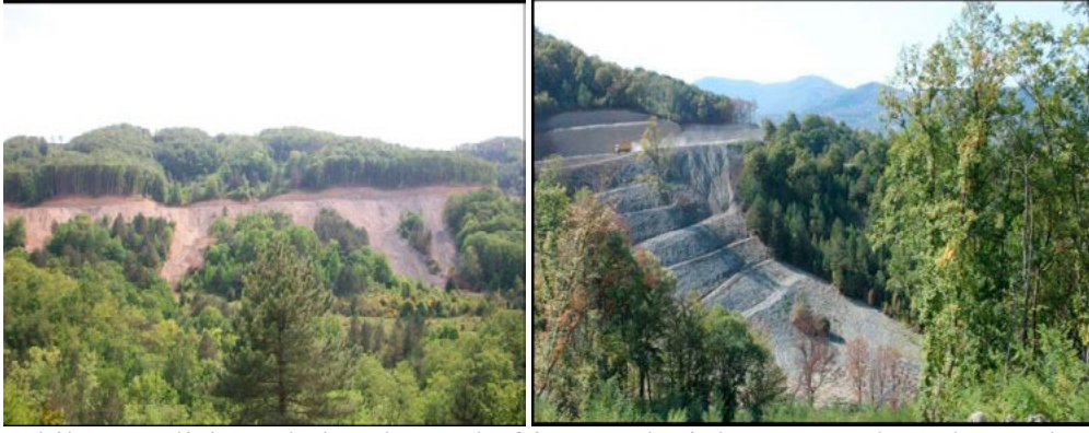
Şekil 5. Gelişigüzel depolanan hafriyat nedeniyle yamaç doğrultusunda hareket eden topraklar
