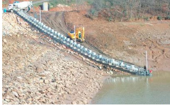
Şekil 1. Tipik bir eğimli su alma yapısı örneği (Denizli).
