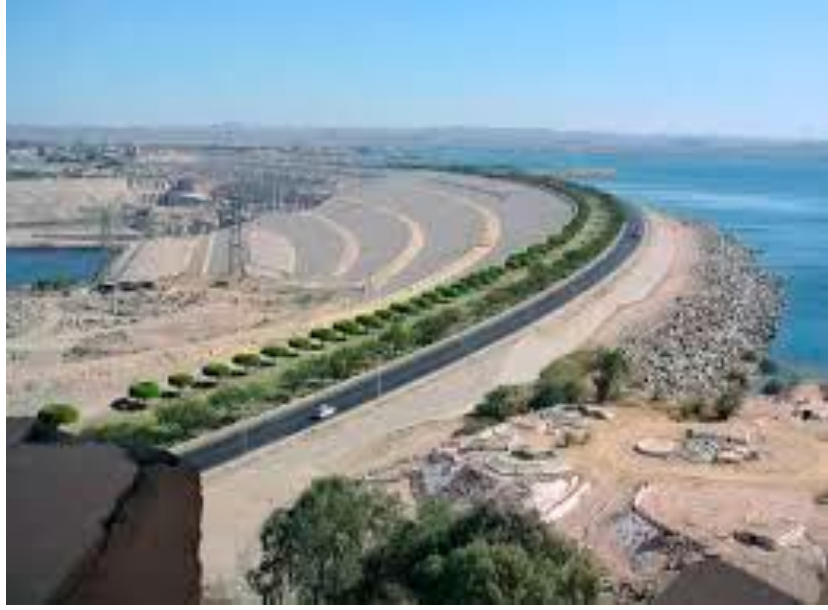
Foto-1. Nil Nehri üzerinde inşa edilmiş olan Aswan Barajı
