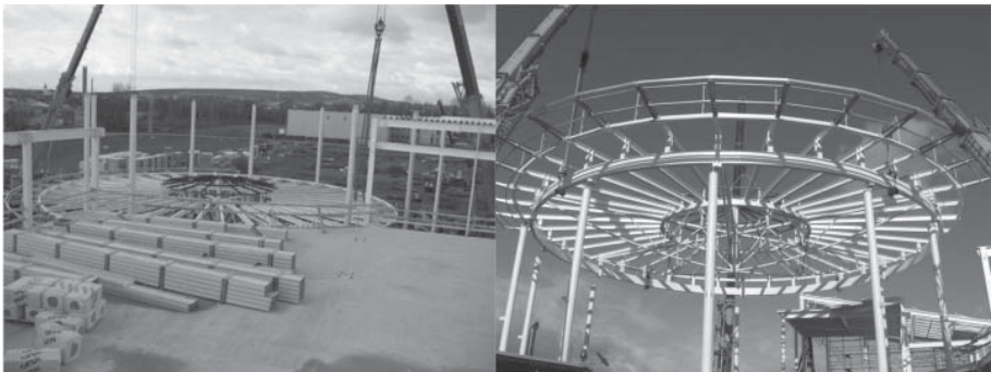
Resim 1 - Yüksekte Çalışmayı Azaltmak - Çelik Yapıların Zeminde Montajı, Kaldırılması
