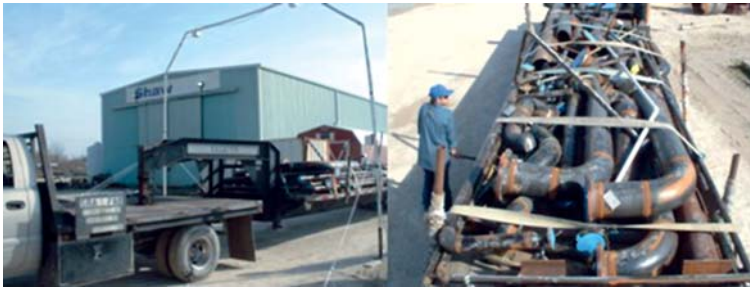
Şekil 2 - a) Treylere şantiyeye girişi b) Rafineri borularının treyler üzerindeki yerleşimi
